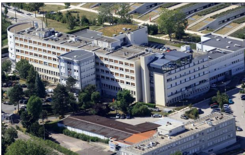
■ Le centre Georges-François-Leclerc est passé de 7 000 mètres carrés à l'origine à près de 25 000 mètres carrés aujourd'hui. Photo Dominique GRANDEMANGE
