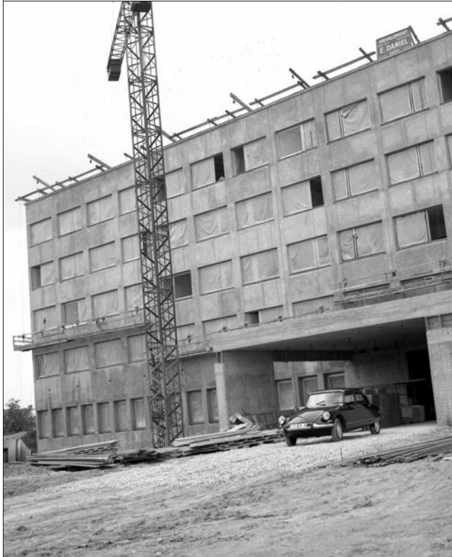
■ Le 6 juillet 1966, le centre est en pleine construction, rue du Professeur-Marion, à Dijon. Photo archives LBP
